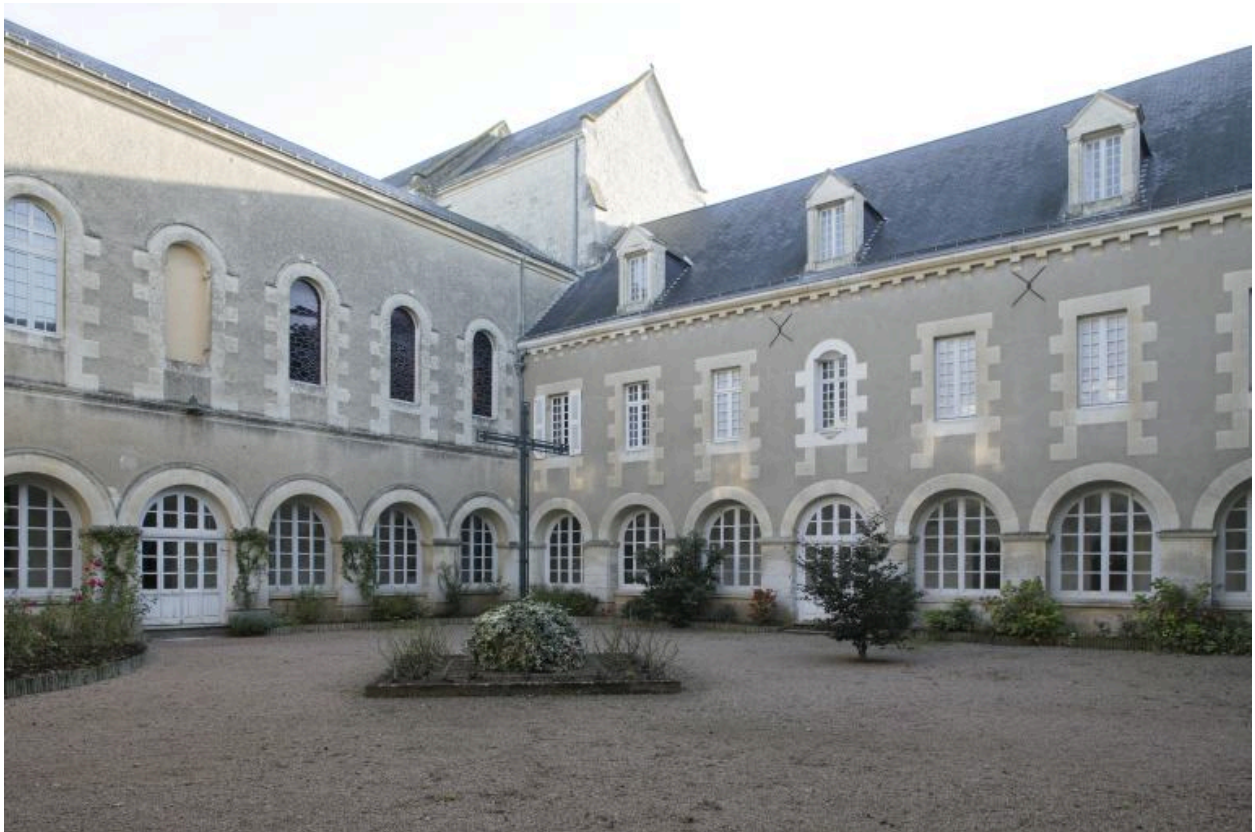
Vue des bâtiments conventuels, prise du sud-ouest du préau.
