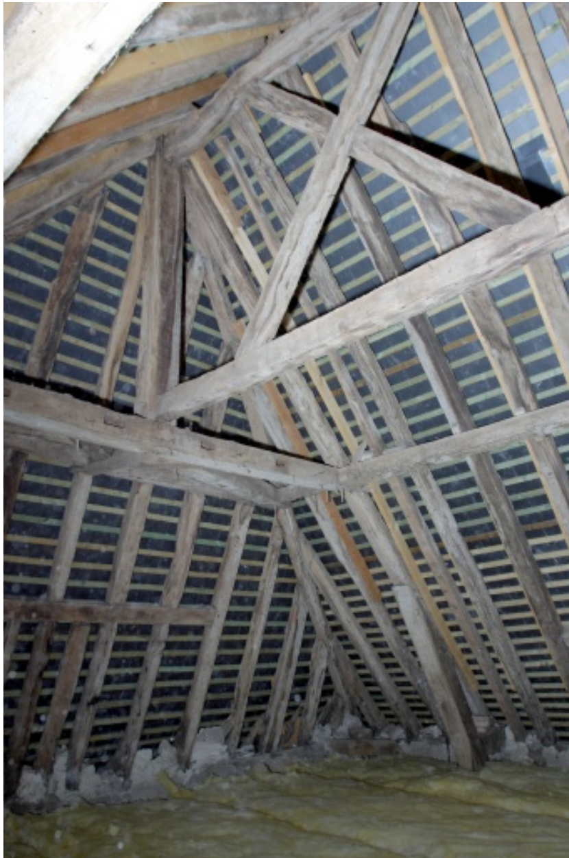
La charpente de la partie sud vue depuis le nord.
