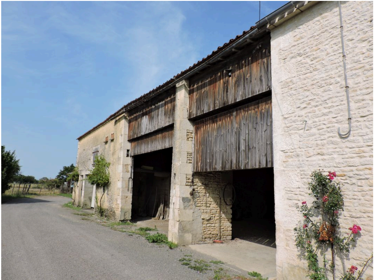
Le hangar en pierre et la grange-étable dans le prolongement sud du logis, vus depuis le nord-est.
