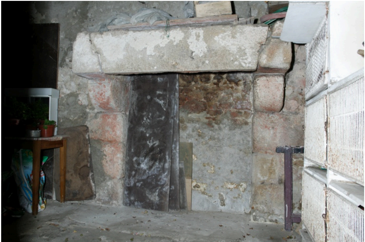
Cheminée de la dépendance.
