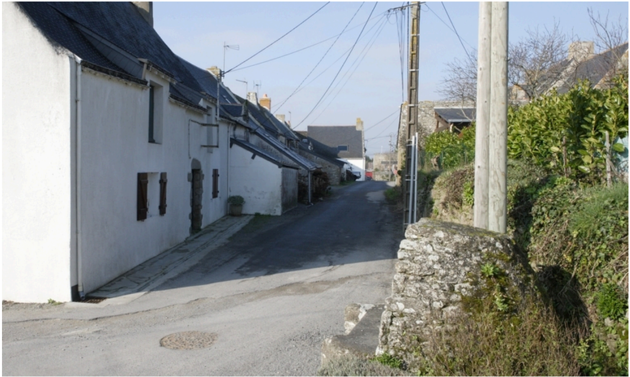
Vue du n° 12 rue du Rigouic.
