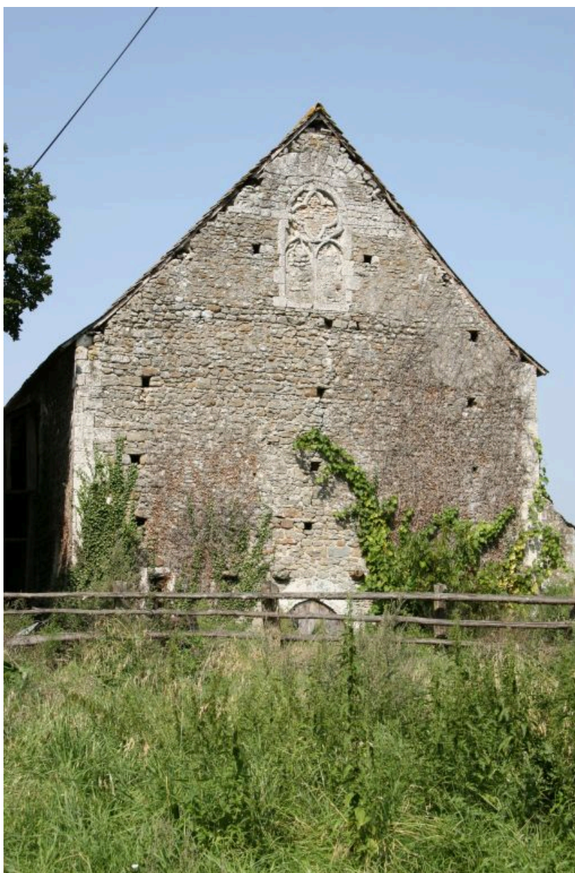
Pignon sud : baie à remplage quadrilobé.
