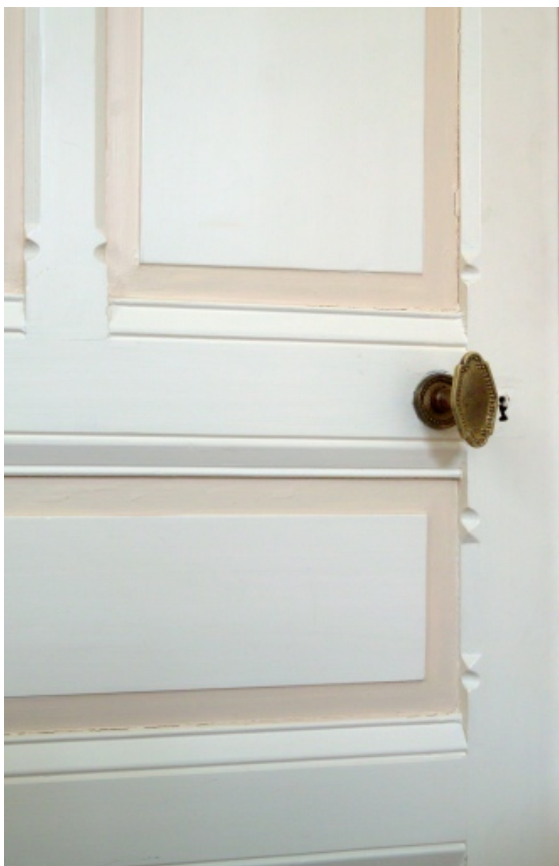
Détail d'une porte du rez-de-chaussée.
