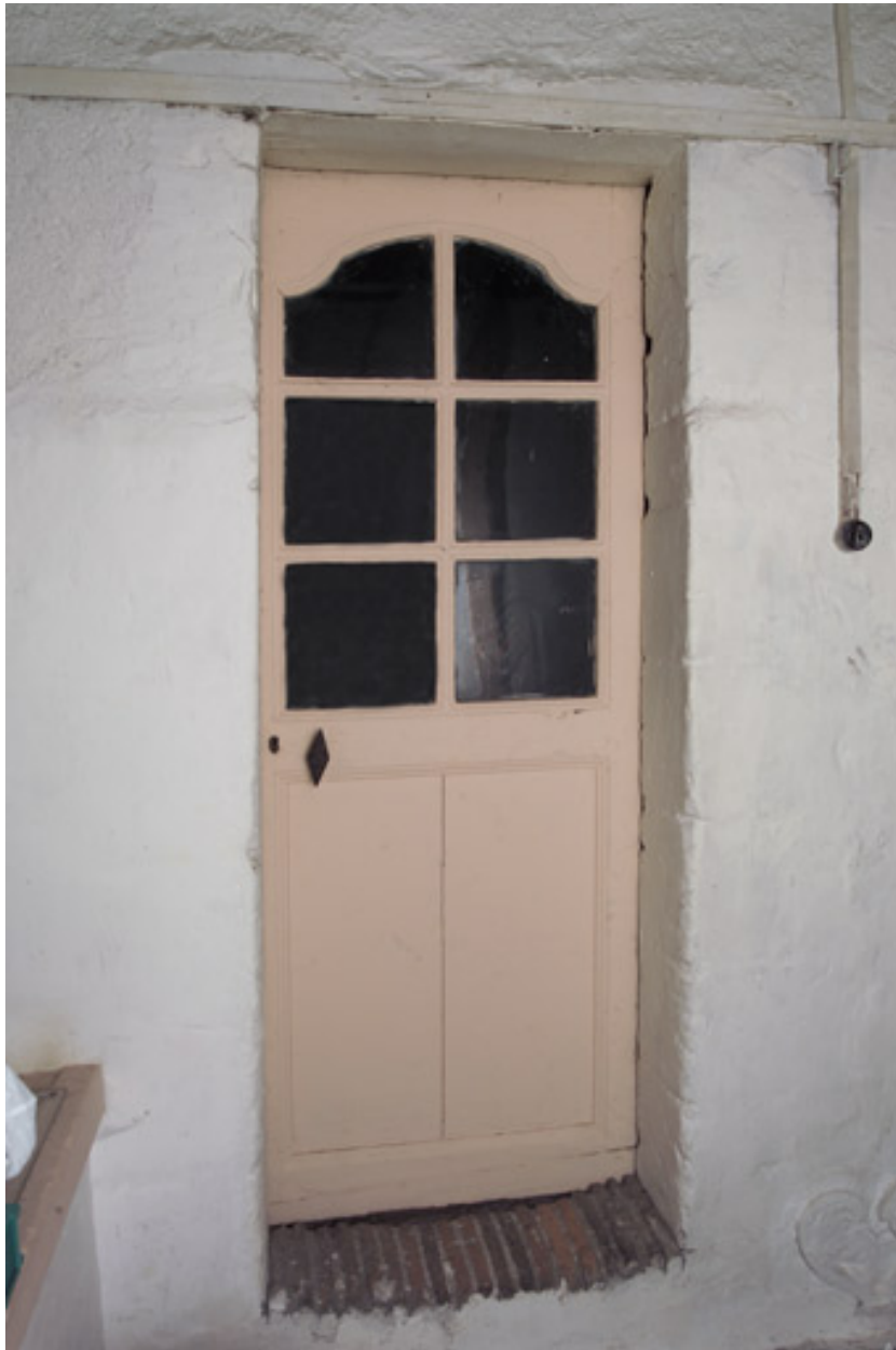
La porte d'accès à la première pièce de l'étage de comble.
