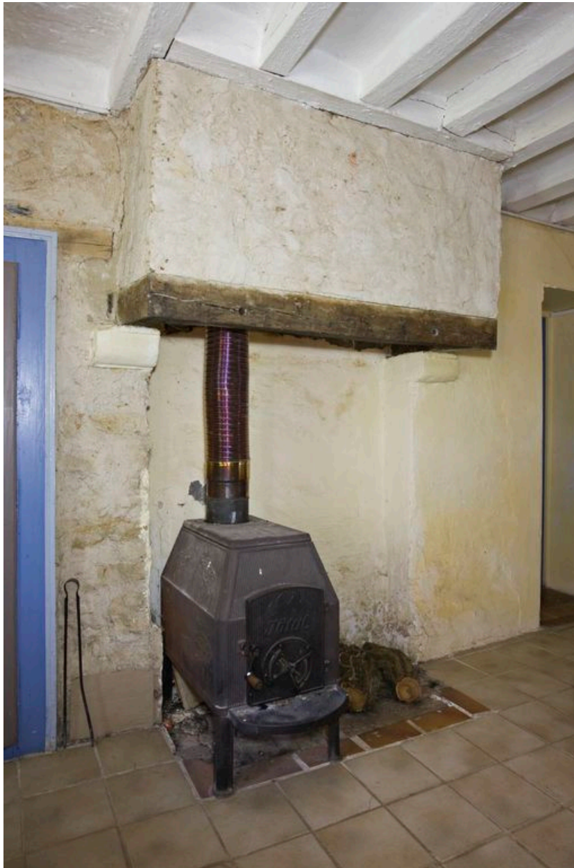
Cheminée de la pièce de gauche, vers 1833
