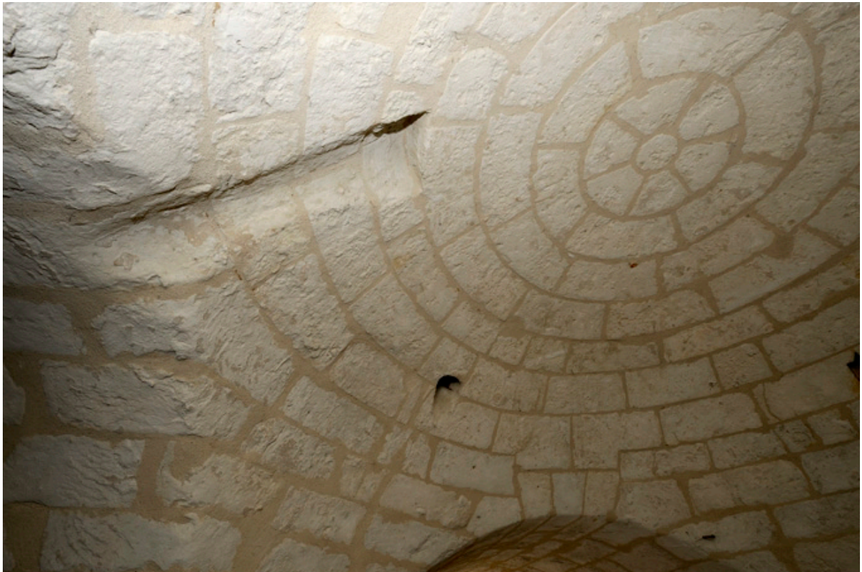
Moulin Picard (intérieur) : voûtes de la cave et du massereau (3).
