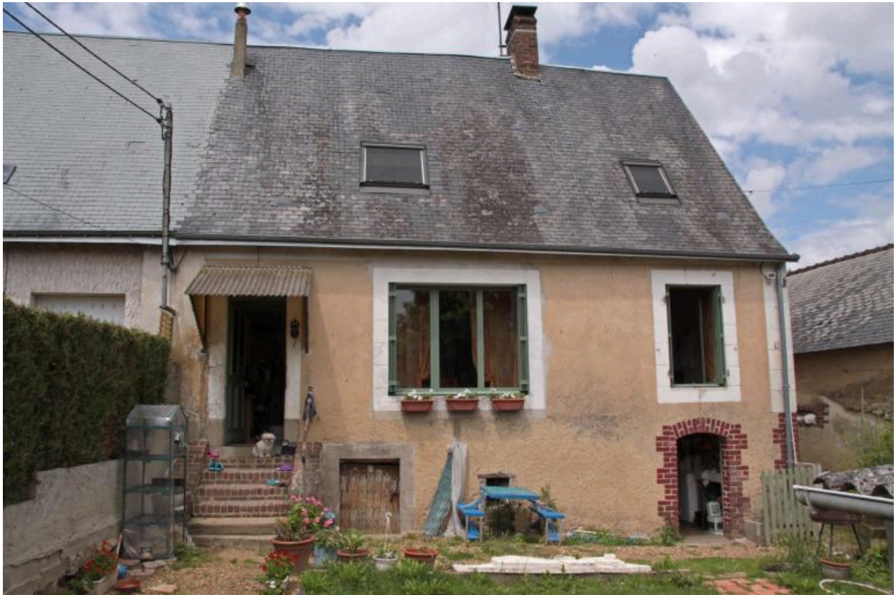
Maison n° 2 : façade sud, habitation actuelle est.
