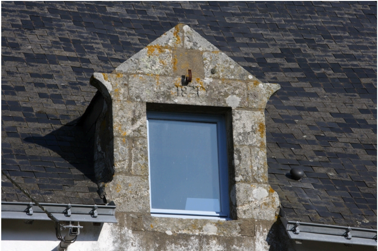
Détail de la lucarne du n° 12 rue de Kerbézo.
