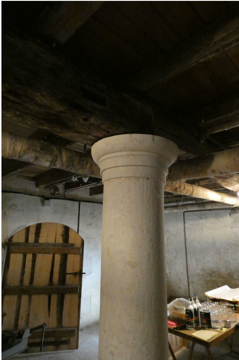
Une des colonnes soutenant le plafond du sous-sol.
