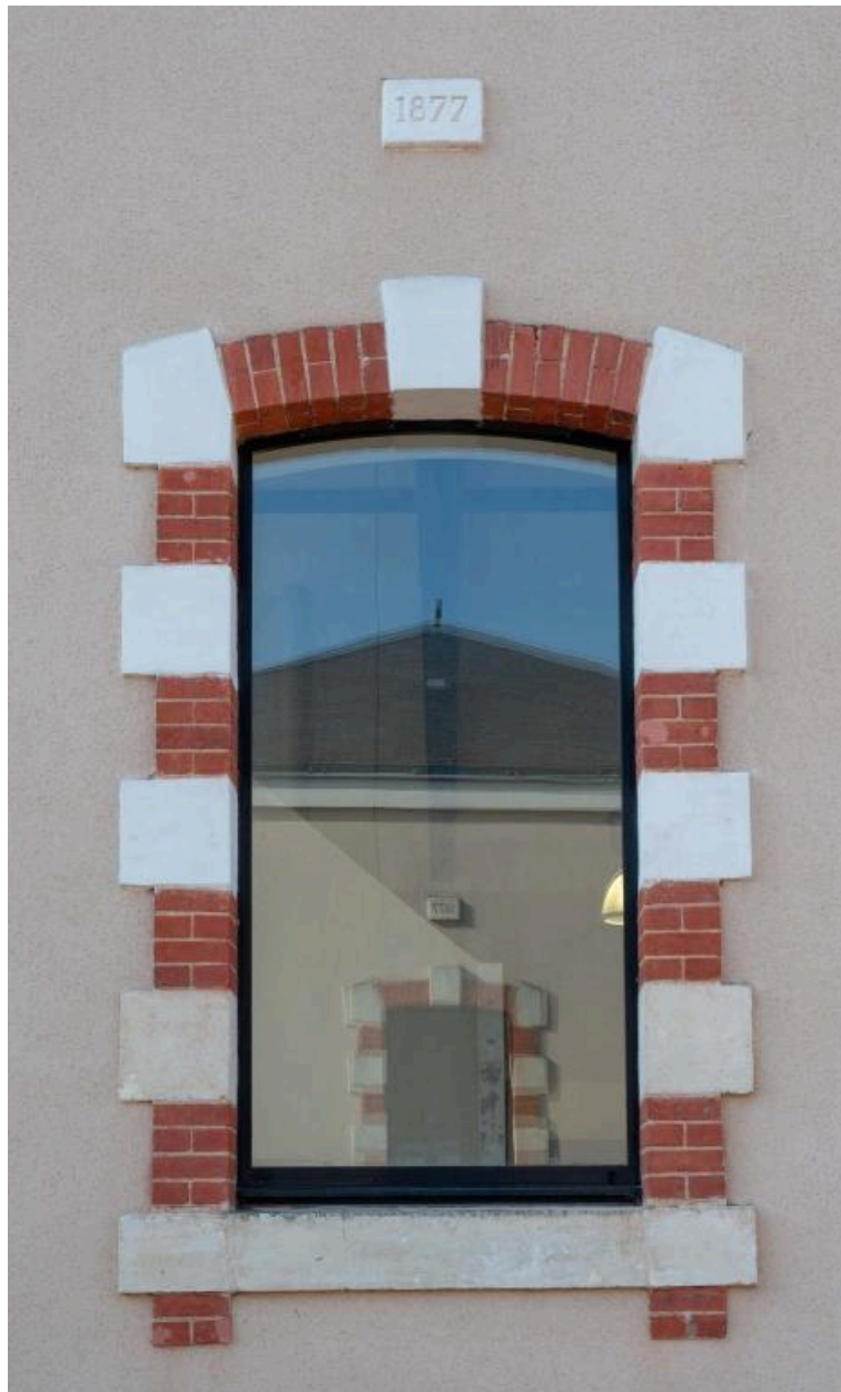
Détail d'une fenêtre et date portée sur le pavillon d'entrée.
