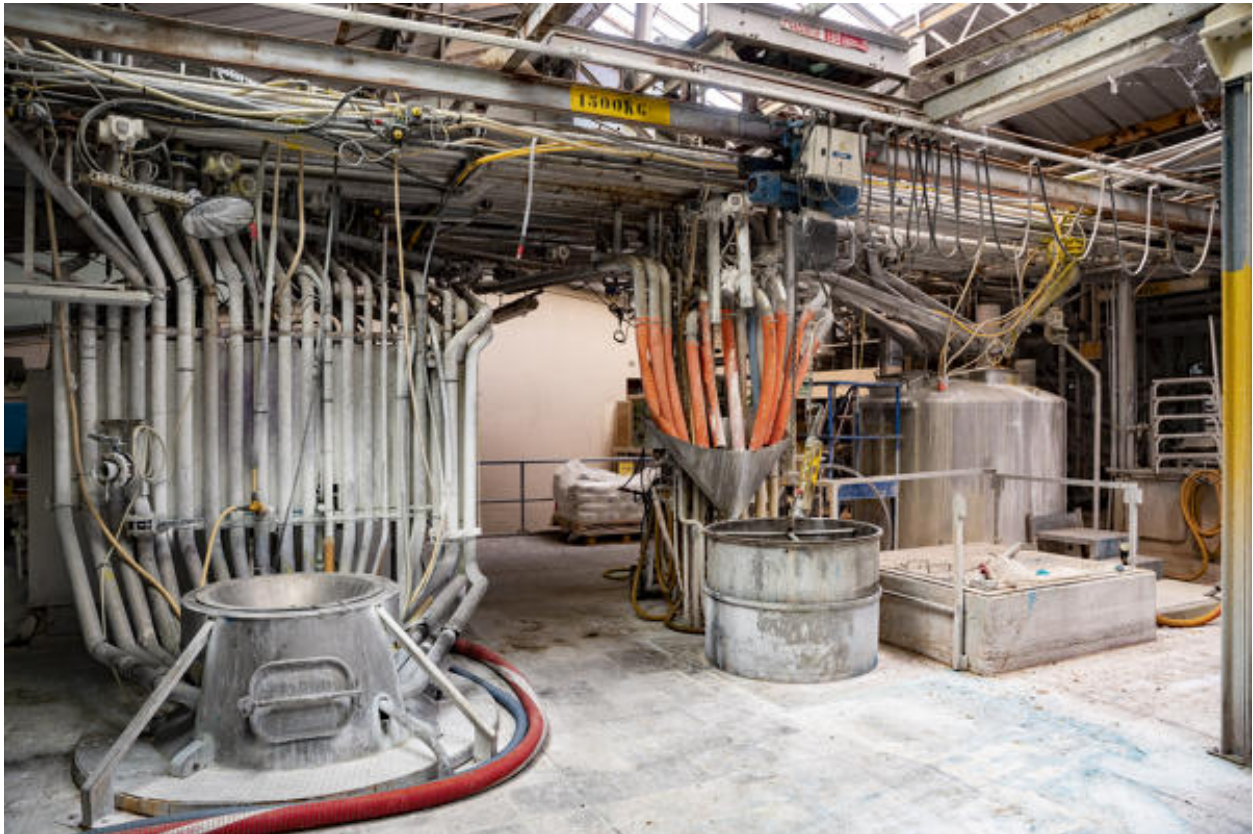
Vue intérieure des réaménagements de l'atelier de couchage B.
