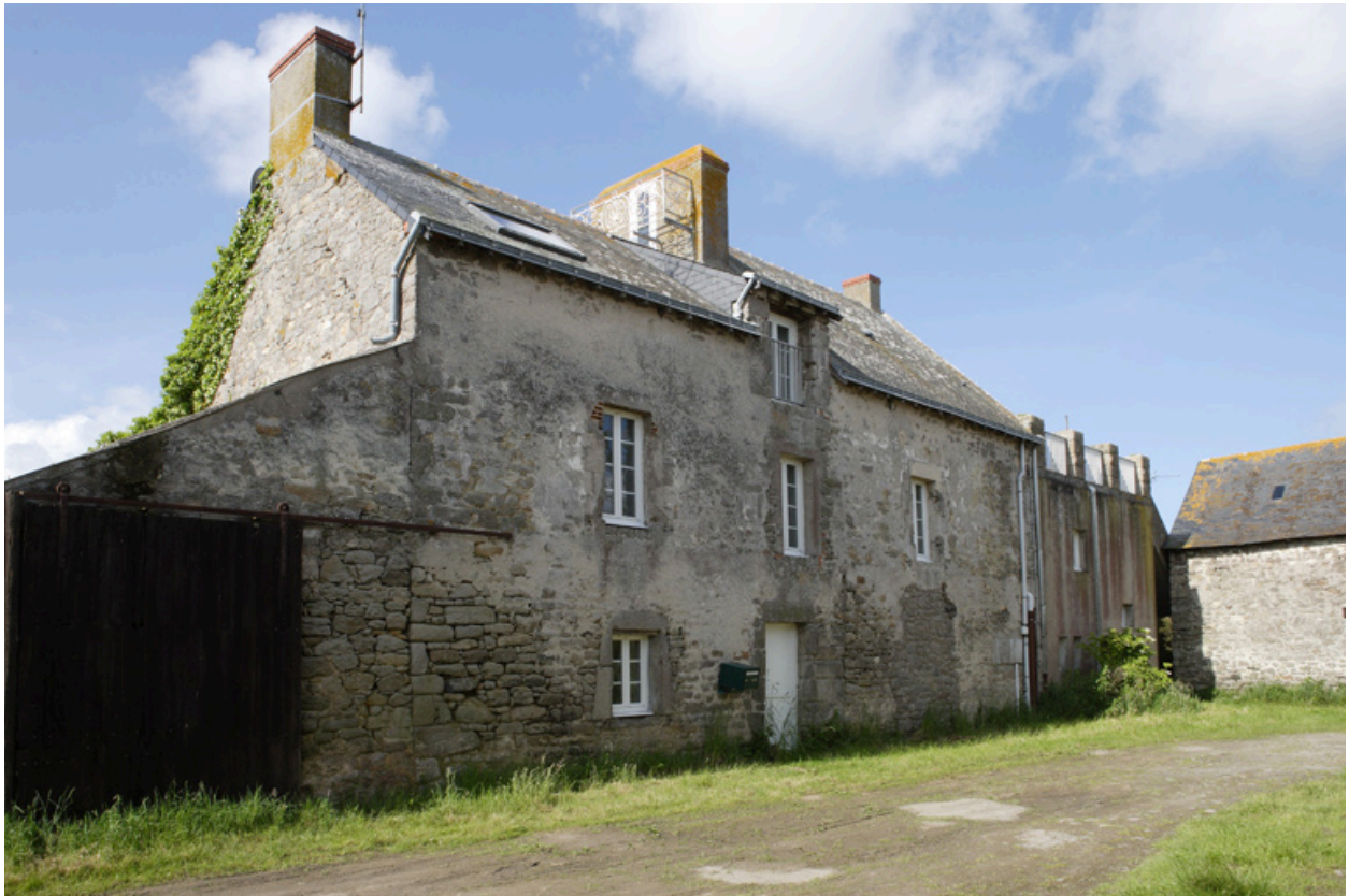
Logis. Vue de trois-quarts depuis le nord-est.
