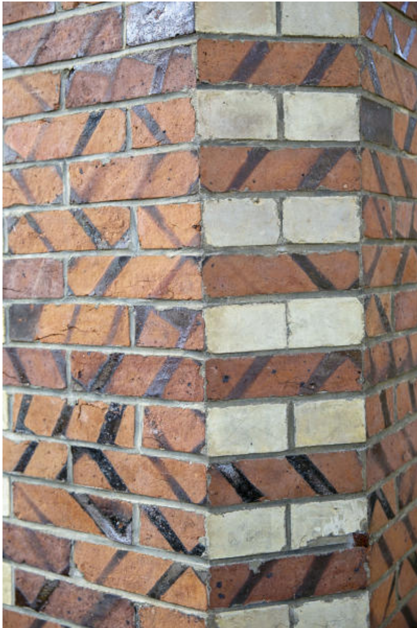
Un détail de décor en brique, rue des Sablons.
