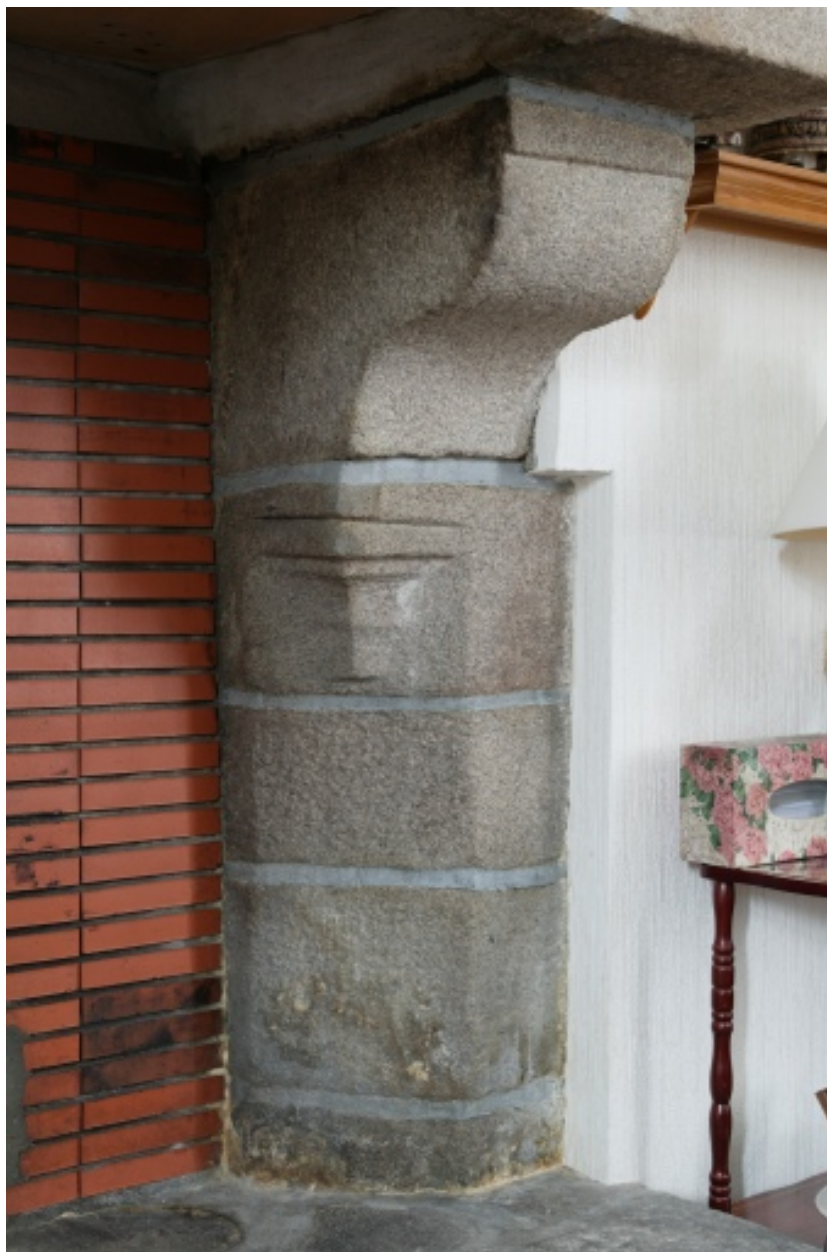
Détail piédroit gauche de la cheminée.
