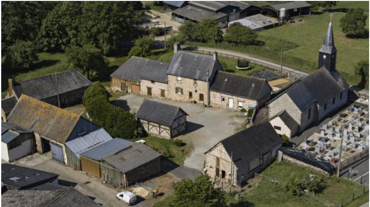
Bourg de Rennes-en-Grenouilles, vue aérienne, depuis le nord-est.
