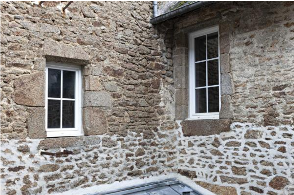
15 Grande-Rue, angle entre la galerie et le corps de logis arrière, baies du premier niveau chanfreinées.
