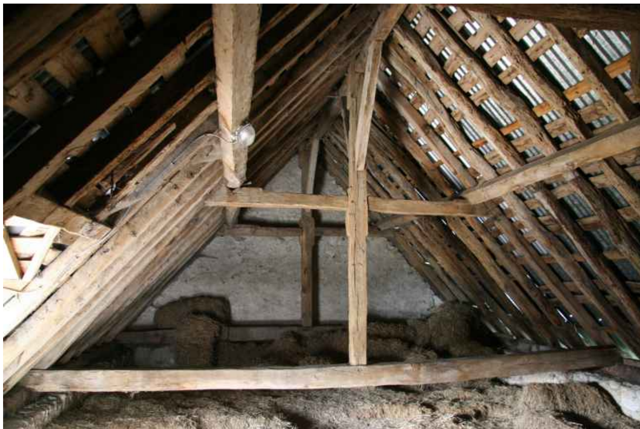
Les étables : charpente à pannes.
