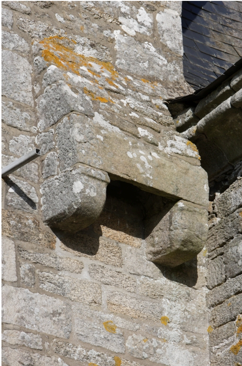
Logis. Tour d'escalier. Détail de la bretèche.
