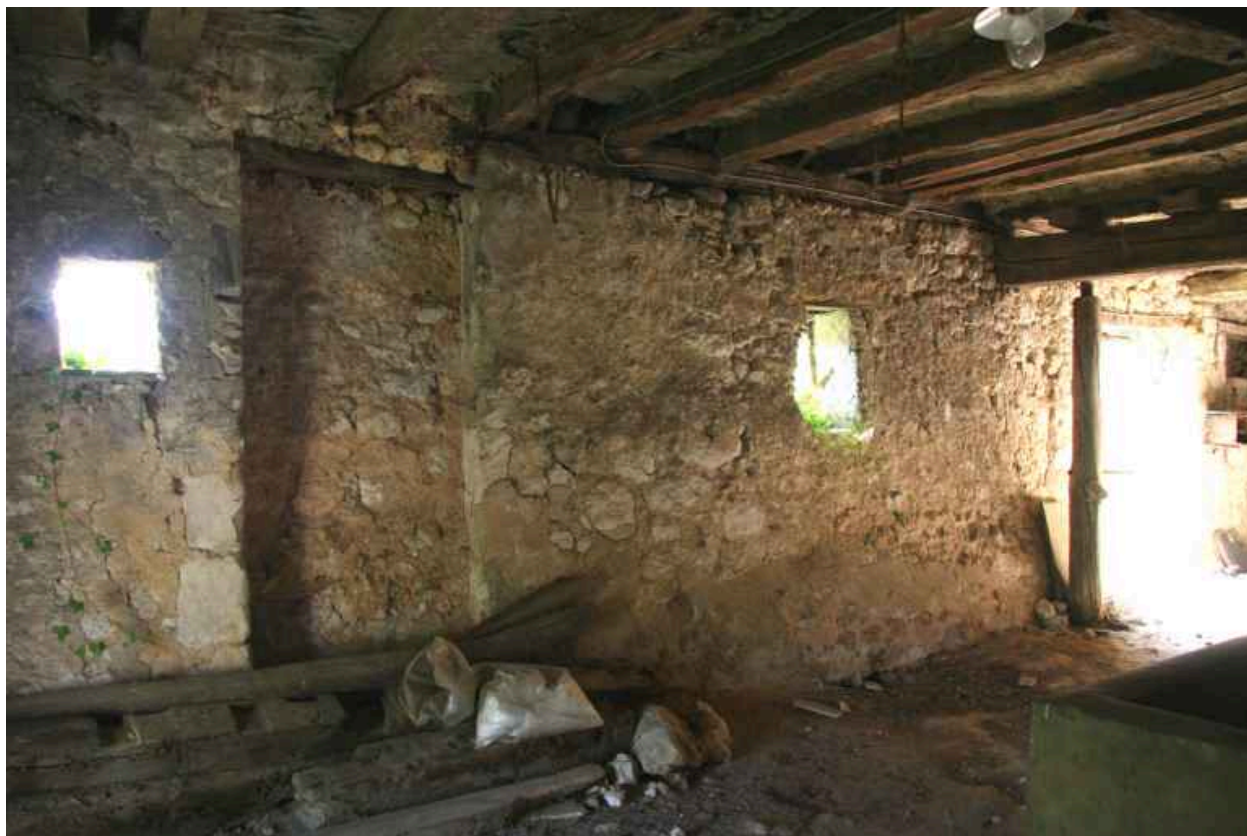
2e maison, dépendances : revers de la façade sur cour.
