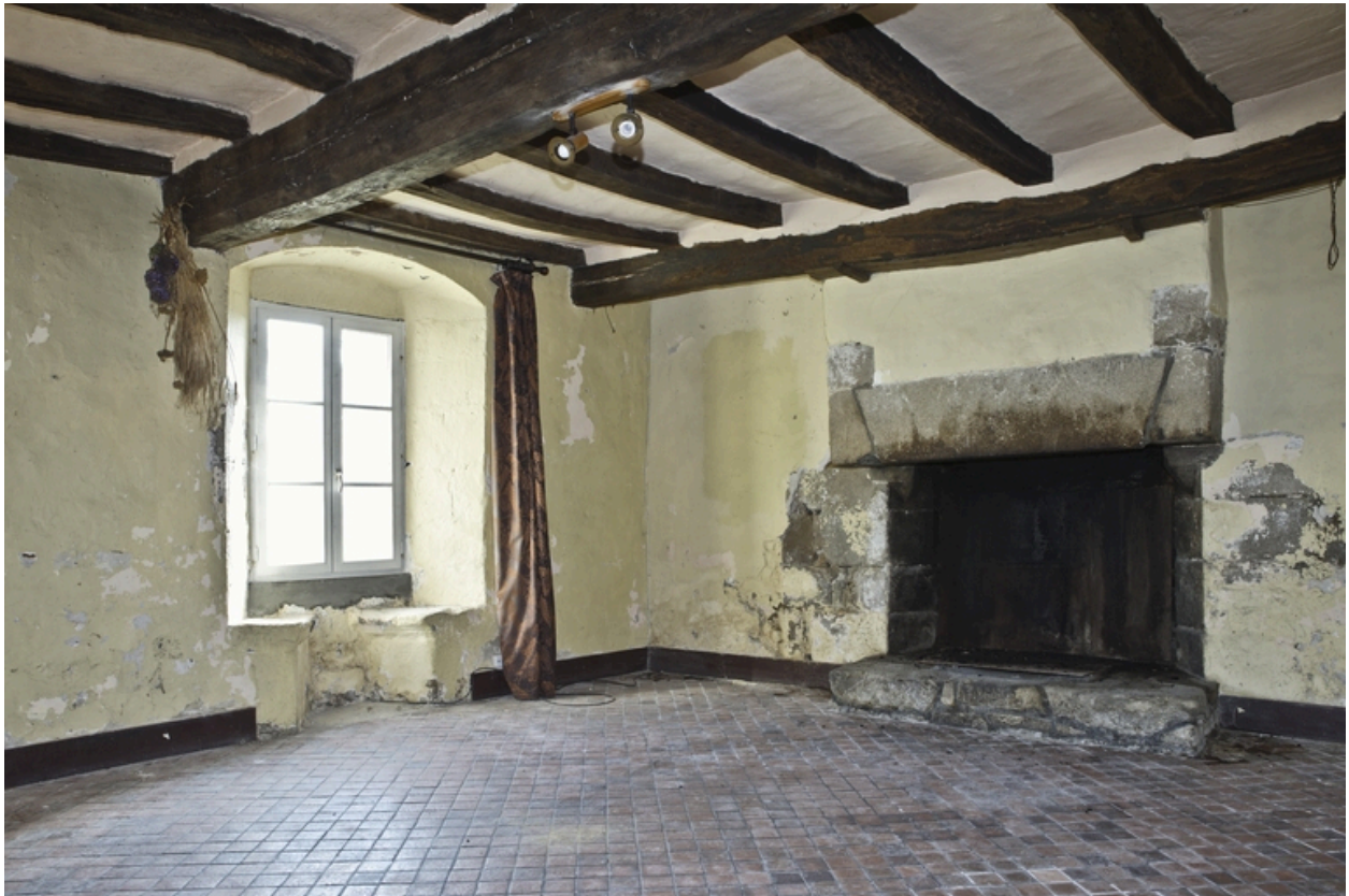
Aile ouest. Salle basse. Vue d'ensemble.
