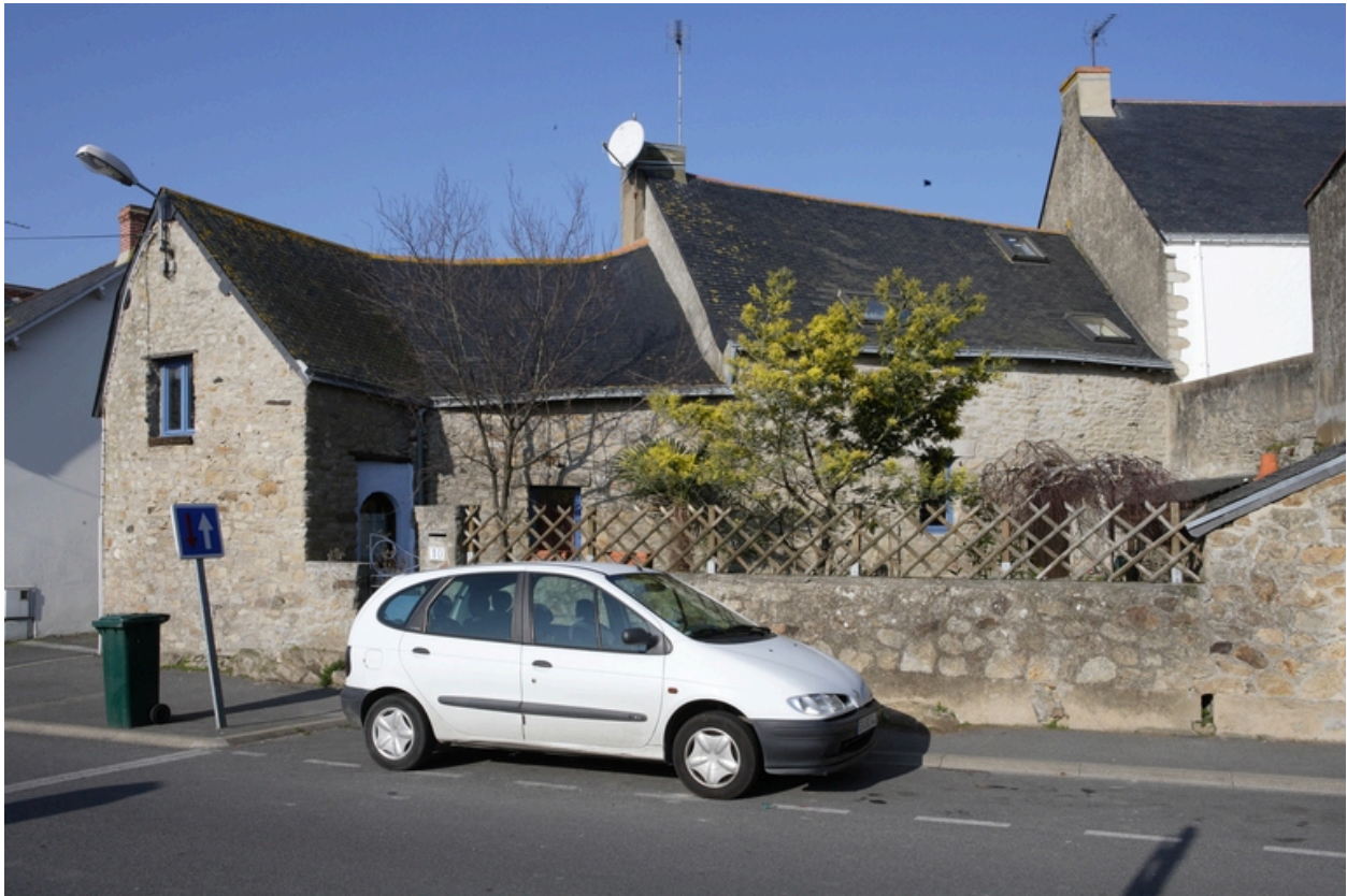
Façade arrière du n° 13 rue Courte-Baille.
