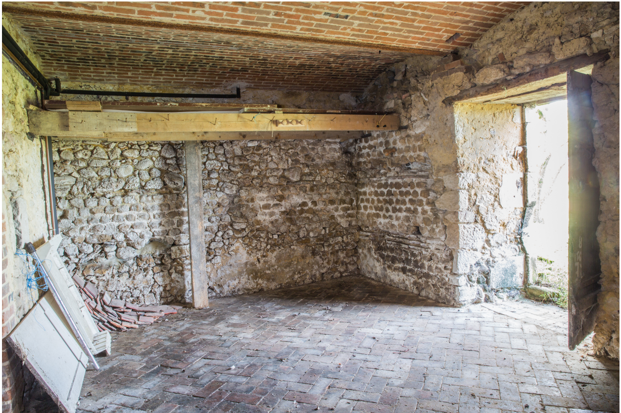
Les anciennes substructions dans la cave.
