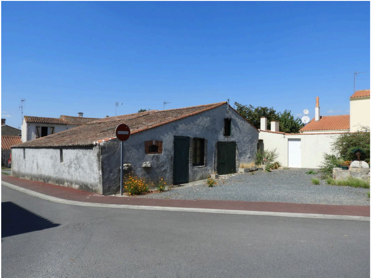
L'ancien chai vu depuis le sud.
