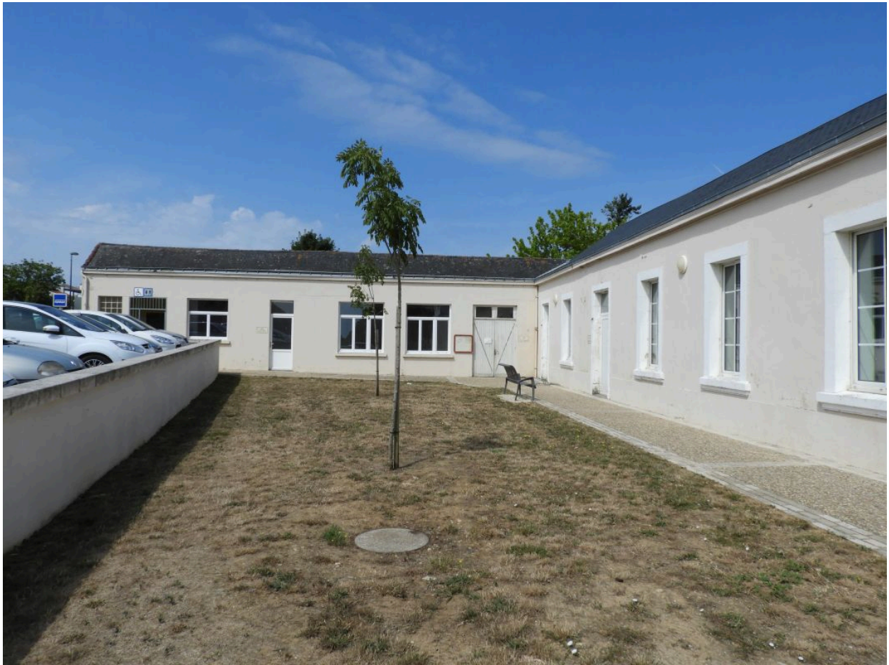
La salle des fêtes et son aile ouest en retour d'équerre vues depuis l'est.
