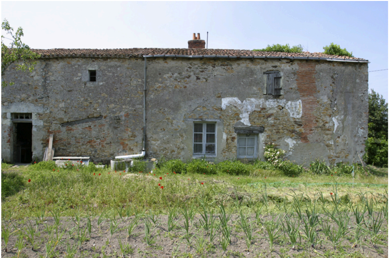
Vue partielle vers le nord.
