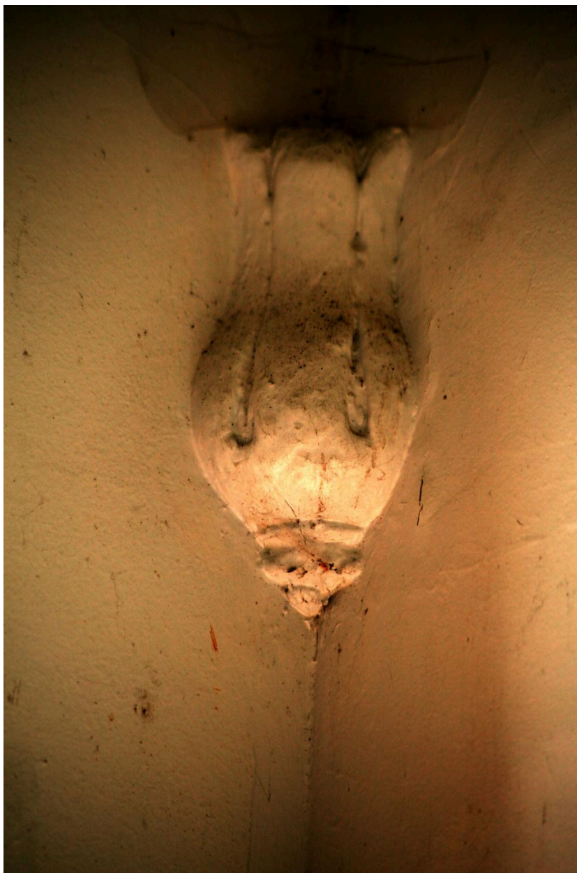
Rez-de-chaussée, voûte du vestibule : culot 6.
