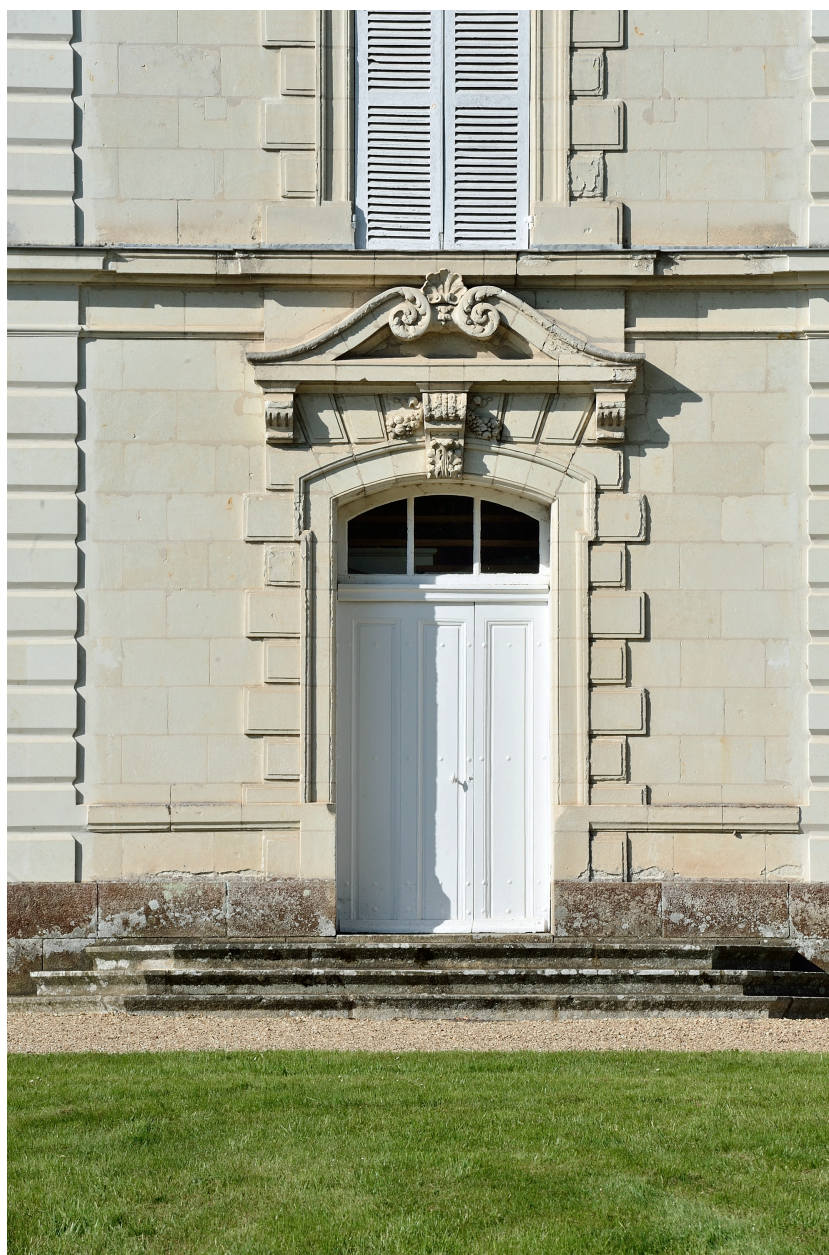
Façade est. Détail de la porte de la travée centrale.
