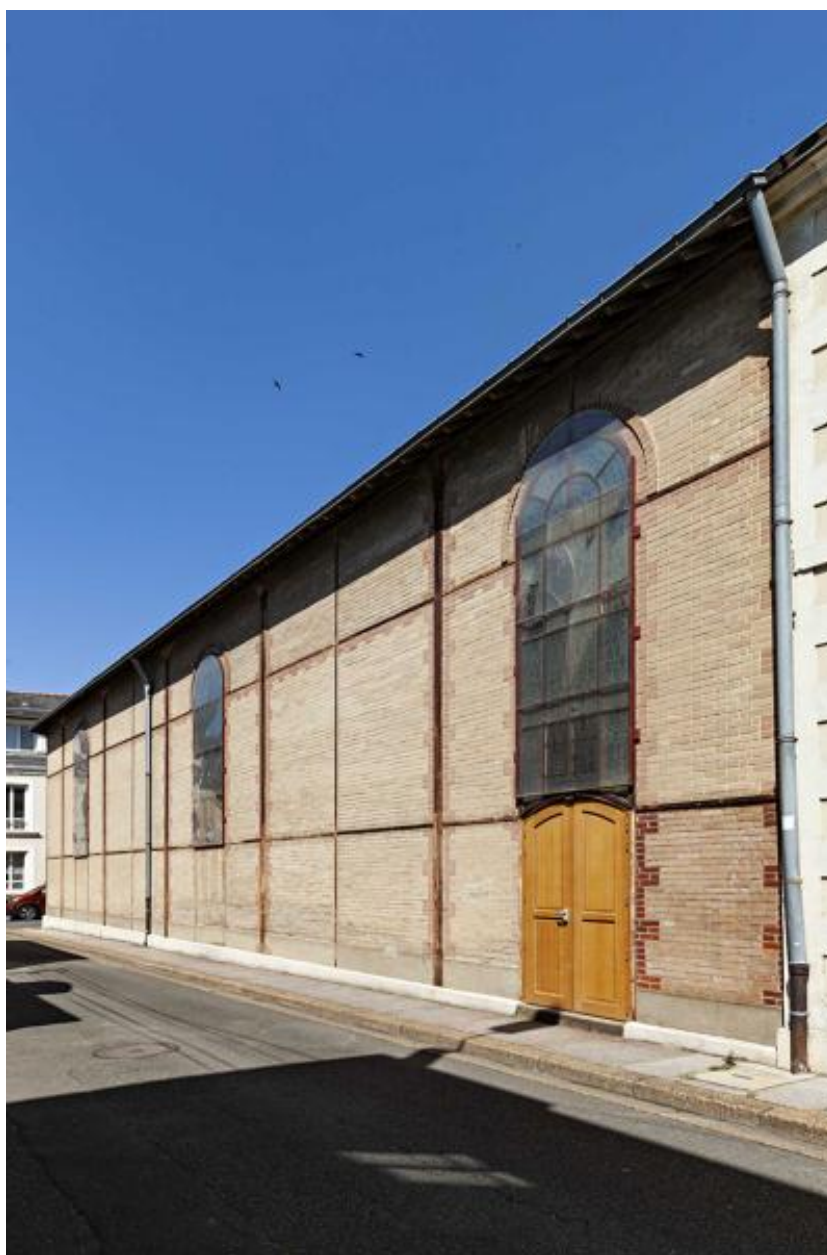
Vue de la chapelle depuis l'est.
