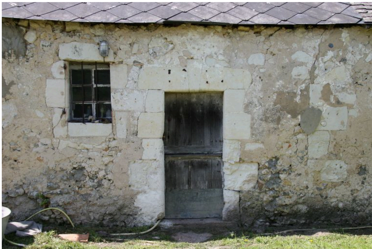
Maison 1, détail : porte et fenêtre fin XVI e siècle ?
