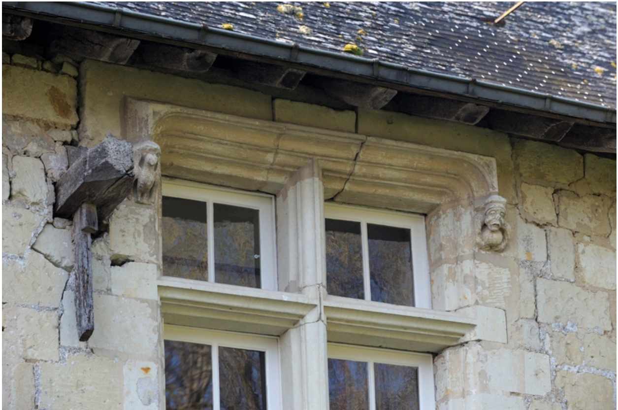
Logis. Manoir médiéval. Façade nord, fenêtres hautes (est), avec tirant en bois (XIXe siècle) et vestiges d'une baie clavée et arquée, à droite (XIIIe ou XIVe siècle).
