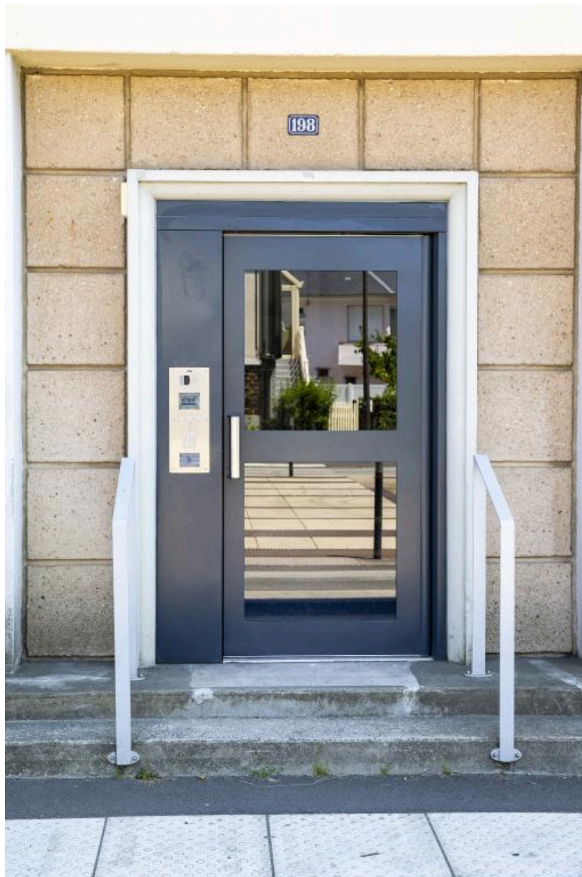
Détail d'une porte d'entrée du bâtiment B1 depuis la rue des Maillets.
