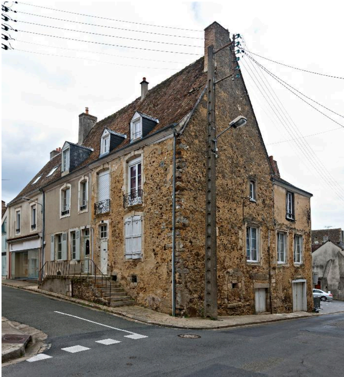
Maison 1, carrefour Saint-Nicolas. Corps principal de la limite des XVe et XVIe siècle, remanié au XVIIIe siècle (élévation sur rue), aile en retour de l'époque moderne, surélevé au XIXe siècle.
