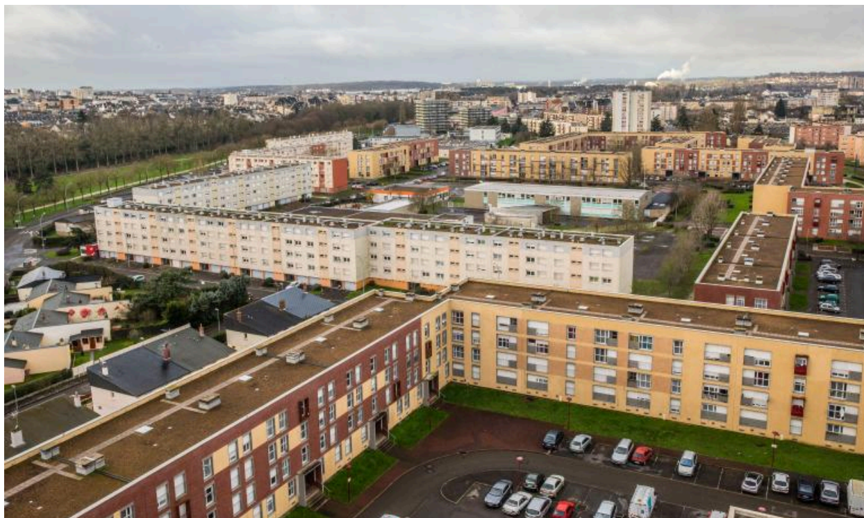
Vue des immeubles de la première tranche, partie ouest.
