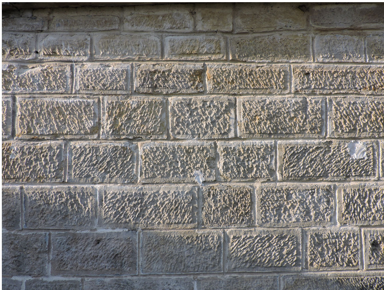
Détail du parement du grand pont.
