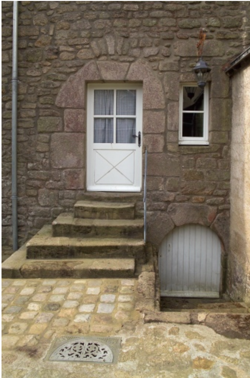
Vue de la porte d'entrée et accès à la cave.
