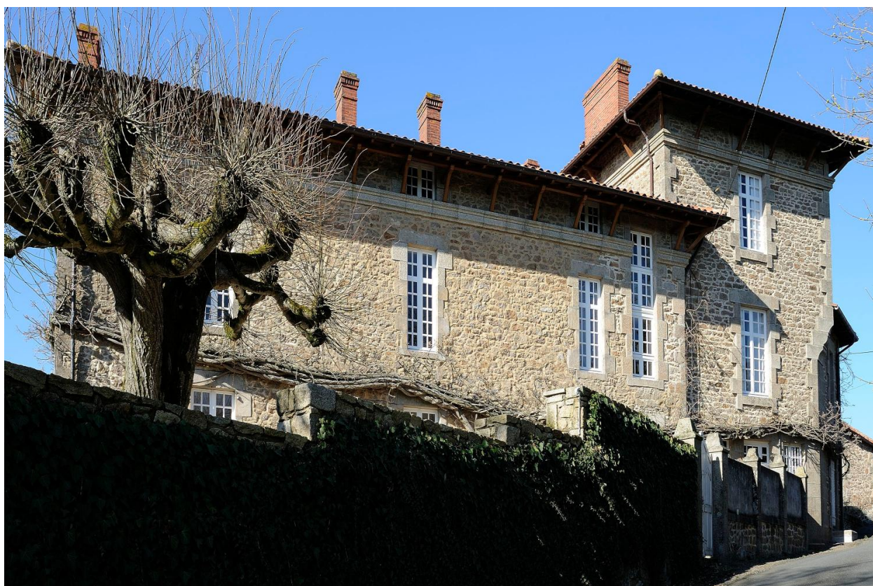
Façade sud-ouest de la propriété.
