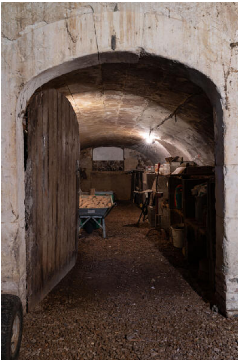
Cellier : porte et intérieur.
