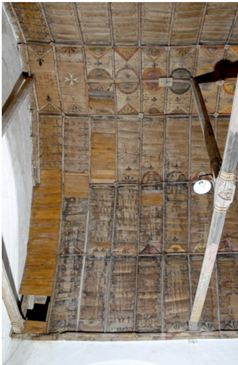
Nef, voûte, côté sud, quatrième travée : vue d'ensemble.
