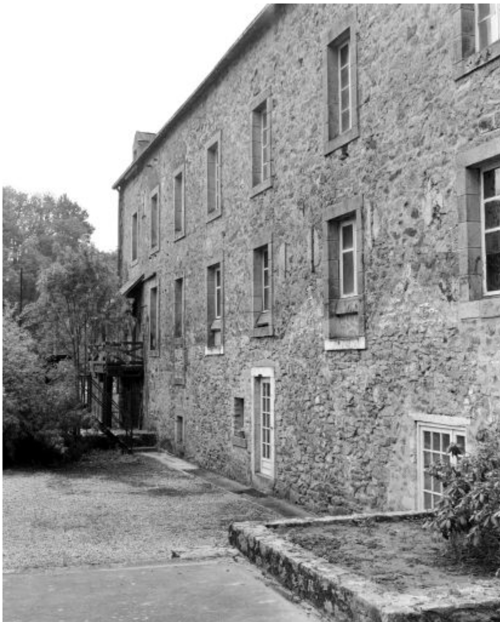
Façade postérieure de l'ancien moulin à farine. A gauche, la vanne régulant l'alimentation en eau d'une des turbines.
