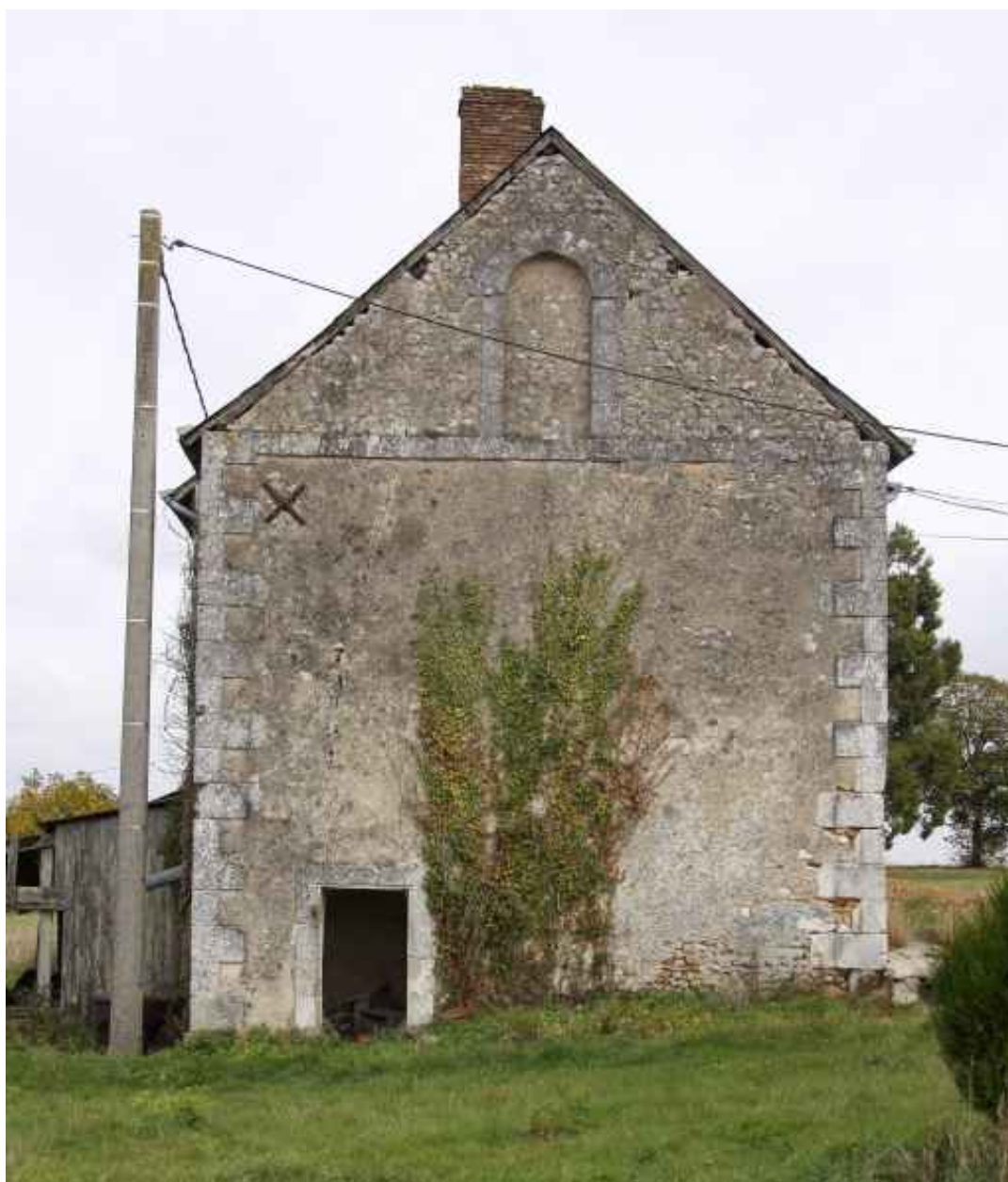
Les étables : pignon ouest.
