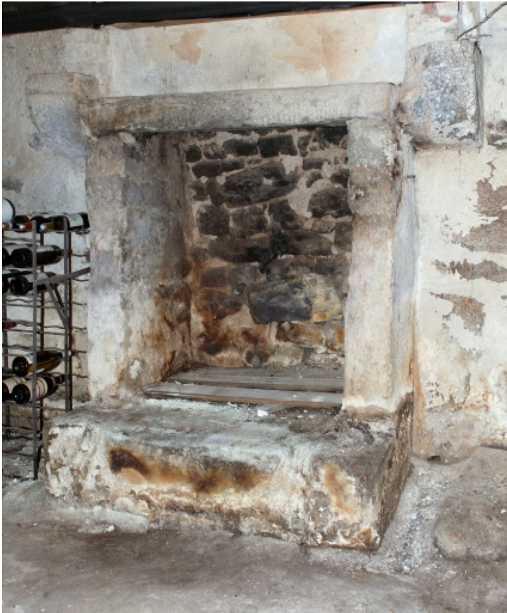
Vue de la cheminée (remaniée) du rez-de-chaussée du logis nord.
