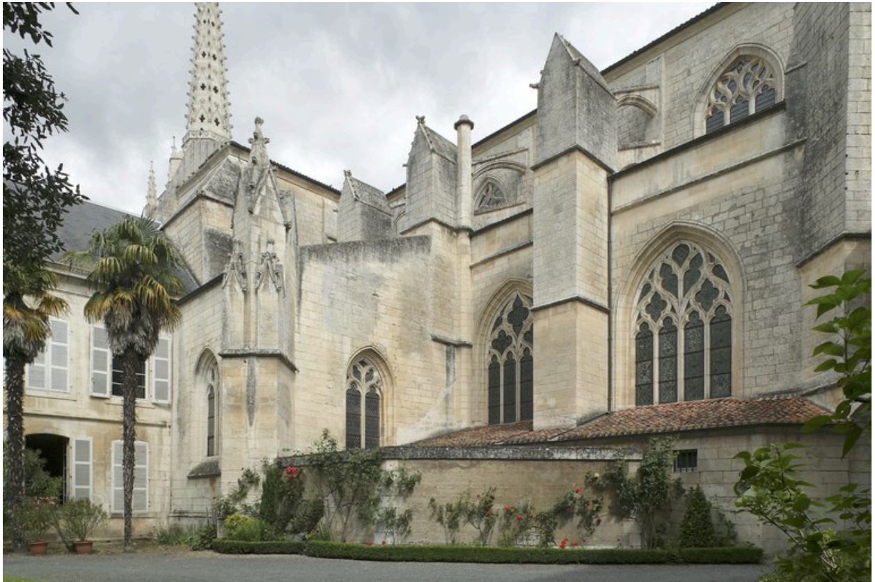
Façade sud du chœur (vue prise du jardin de l'évêché).
