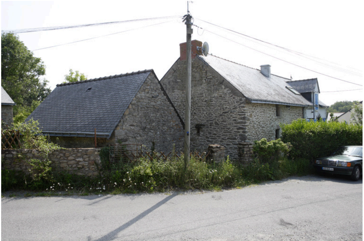
Vue d'ensemble depuis le nord-ouest (l'écurie à gauche dépend de la 3e ferme).
