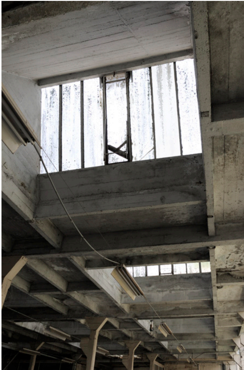
Vue intérieure des sheds.
