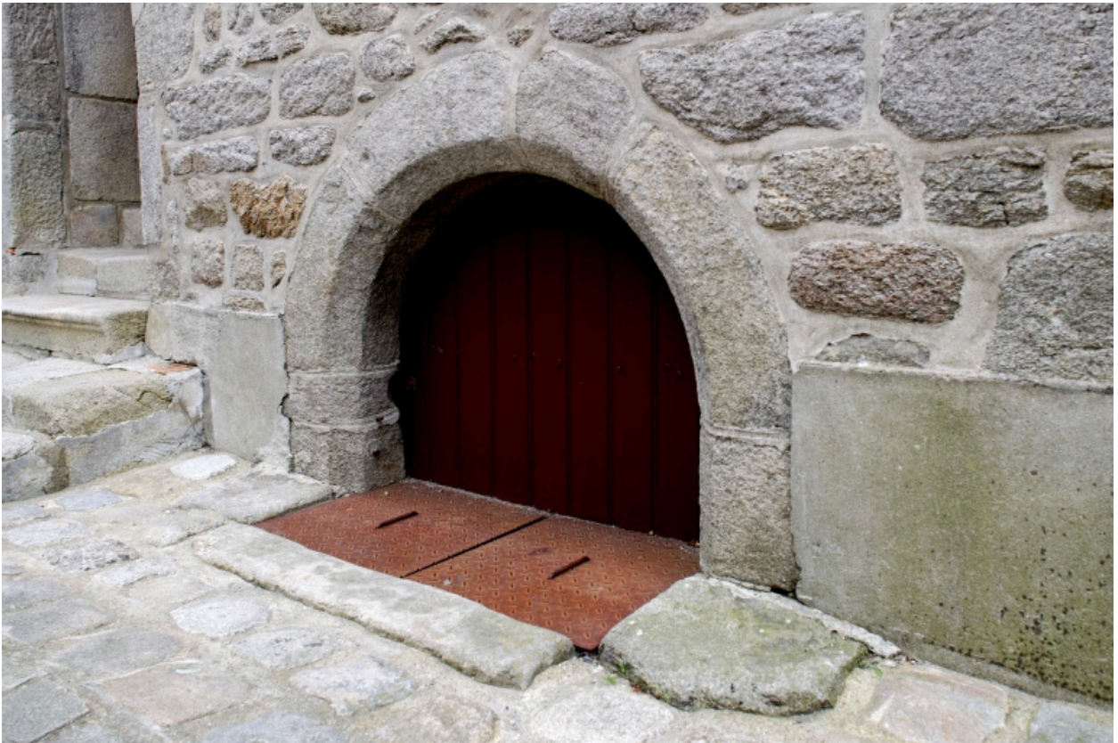
Façade sur rue, détail de la porte de la cave.
