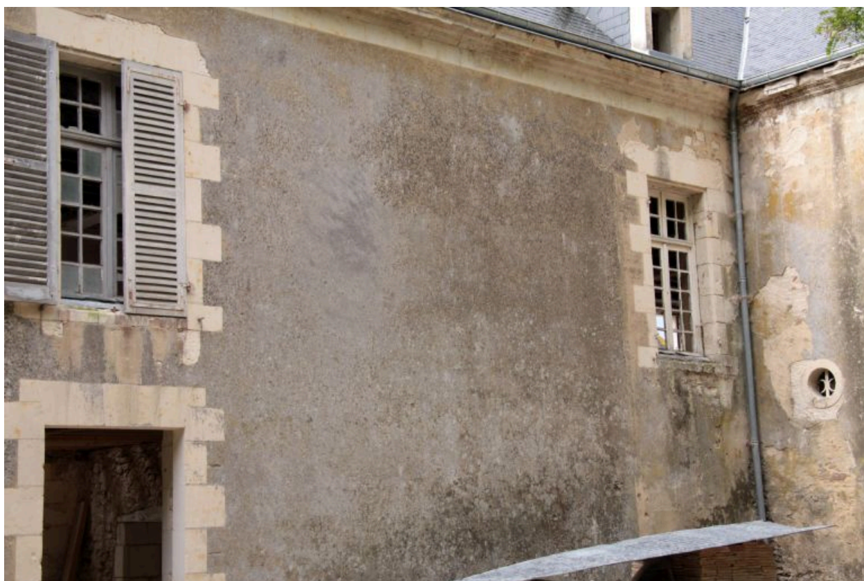
La maison, façade postérieure avec aile en retour, détail.
